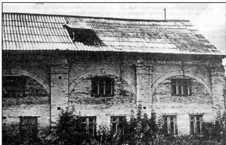
В таком виде сохранилось здание важни. Арки заложены кирпичом с оконными проемами, сделано перекрытие второго этажа. Фото 90-х годов прошлого столетия.
