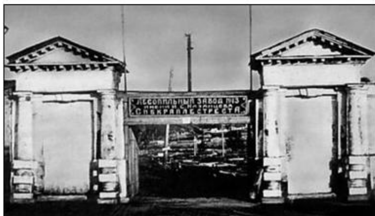
Двухколонные портики на въезде в завод. После революции он носил название «Лесопильный завод № 13 имени И.С.Казанцева Сибкрайлестреста». Фото 1920-х гг
