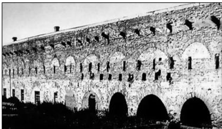
Западная стена второй плавильной фабрики
