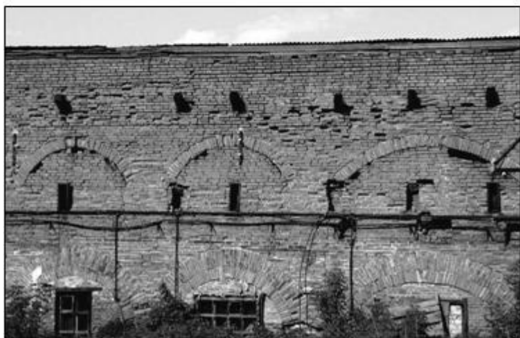
Фрагмент внутренней стены основного цеха второй плавильной фабрики.
