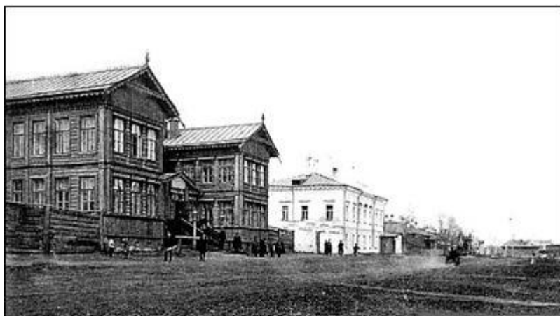
Чертежная Алтайского горного округа на Петропавловской улице. Деревянное здание в формах эклектики, построенное во второй половине XIX века. Здесь в 1917-1919 г.г. размещался Барнаульский Совет рабочих и крестьянских депутатов. Фото из фондов АГКМ.
