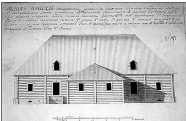
Чертеж соляного магазина, построенного в Барнауле в 1816 г. Выполнен унтершхтмейстером Постниковым. Из фондов ГААК. Ф.50. Оп.11. Д.797
